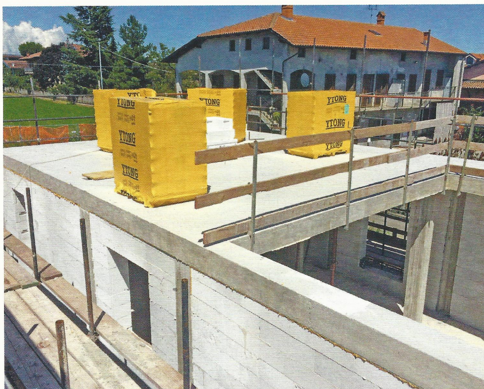
Vista della struttura in CA che si ferma al piano terra, la struttura del sottotetto è stata realizzata in muratura portante per l'appoggio della copertura.
